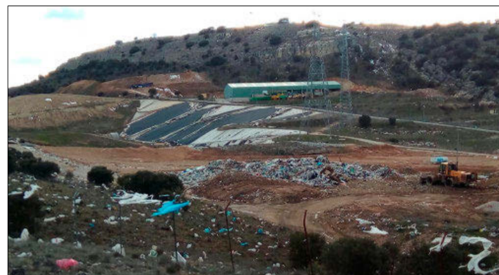
El vertedero donde llegaban los residuos. M. T.
