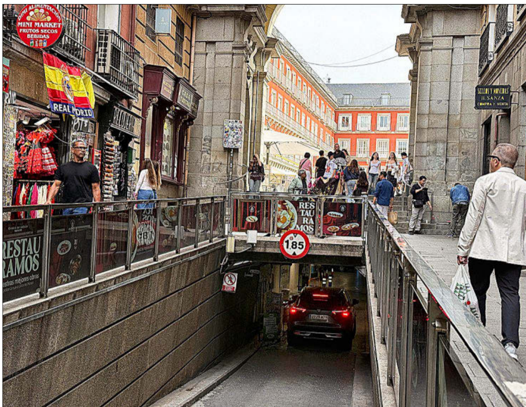
Entrada al aparcamiento municipal de la Plaza de Mayor en el distrito Centro de Madrid. JAVIER BARBANCHO
